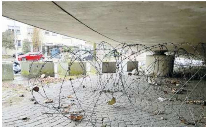
Mit Stacheldraht versperrt: Post beim Bahnhof Basel SBB. Bild: bwi
